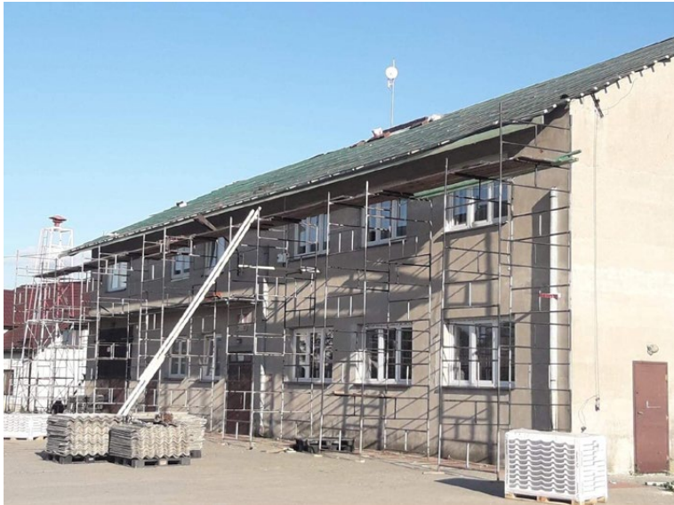
Wymiana i remont dachu 2019 rok
