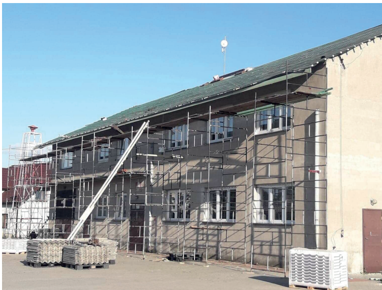
Wymiana i remont dachu 2019 rok
